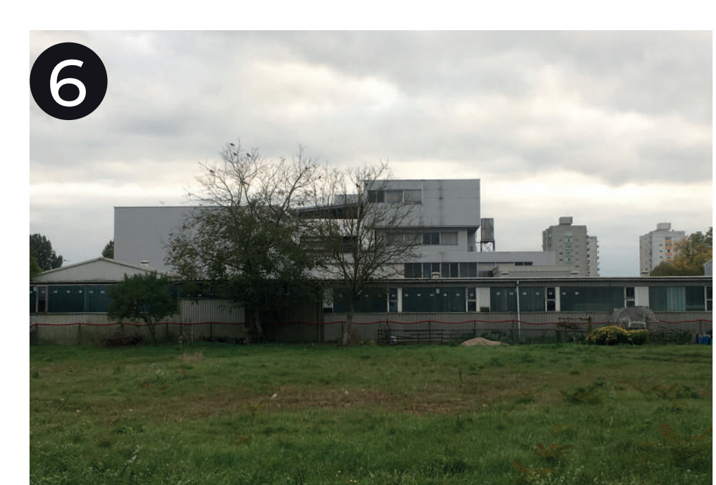
Objekt: Poslovno-proizvodni objekt Medexa Lastništvo: MEDEX, živilska industrija, d.o.o. Stanje: v dobrem stanju, v uporabi
