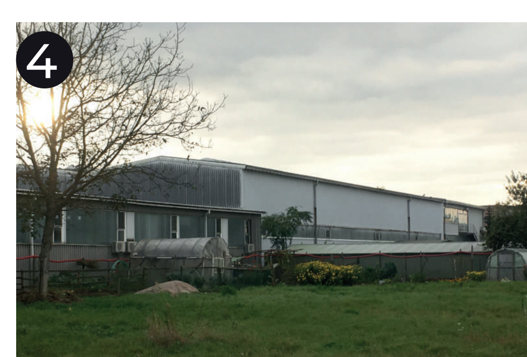
Objekt: Poslovno-proizvodni objekt Medexa Lastništvo: MEDEX, živilska industrija, d.o.o. Stanje: v dobrem stanju, v uporabi
