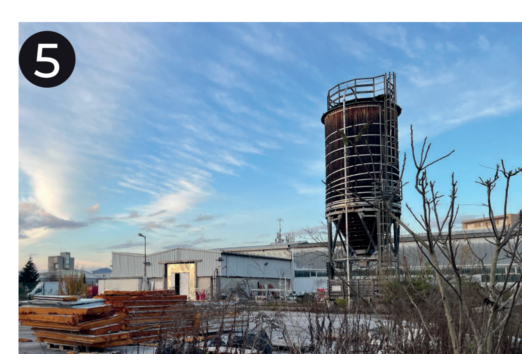
Objekt: Lesen silos Lastništvo: Slovenski državni holding, d. d. Stanje: v slabšem stanju, ni v uporabi
